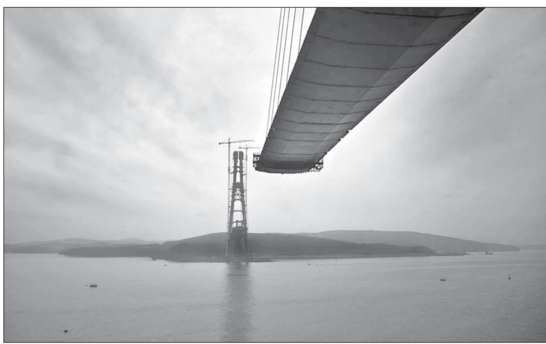
Алексей Майшев. Строительство моста на острове Русский. Владивосток. 2011 г.
